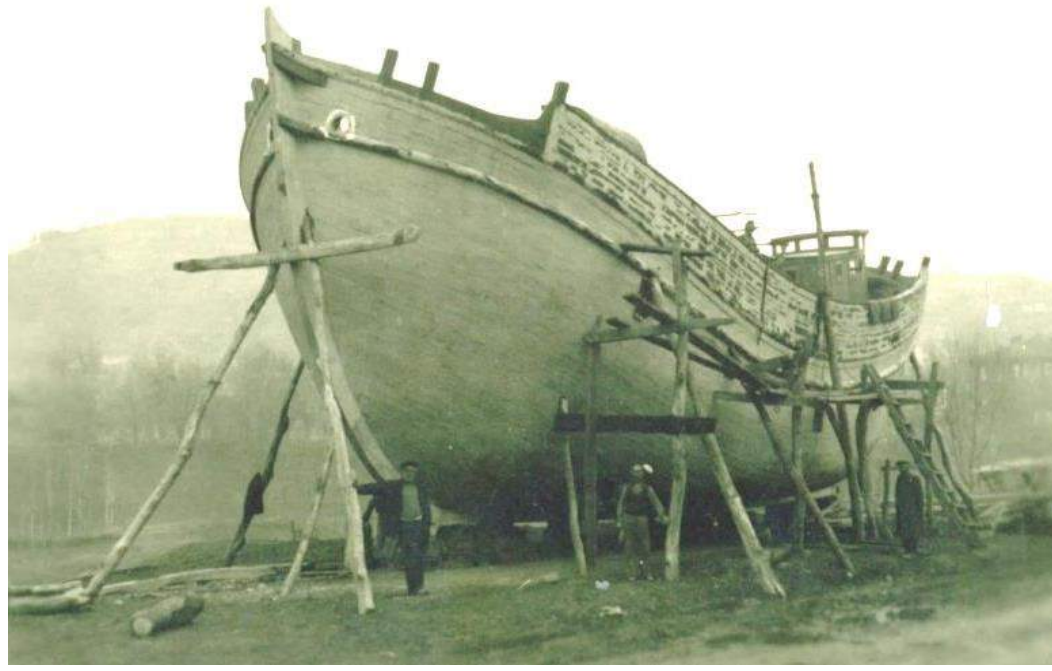
Şekil 14. VANLI gemisi Bartın’da inşa halinde 1965.
